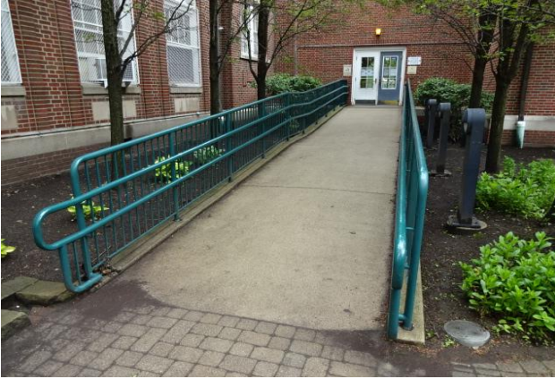
ADA Compliant Ramp
